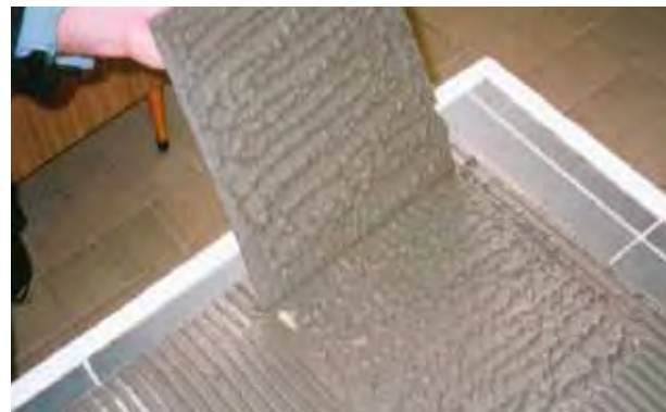
Obr. 2 – Lepení metodou Buttering-Floating
